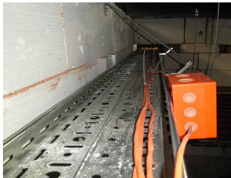
Рис.28 Пример крепления монтажной коробки на поверхности кабельного потка типа ЛПМЗТ
